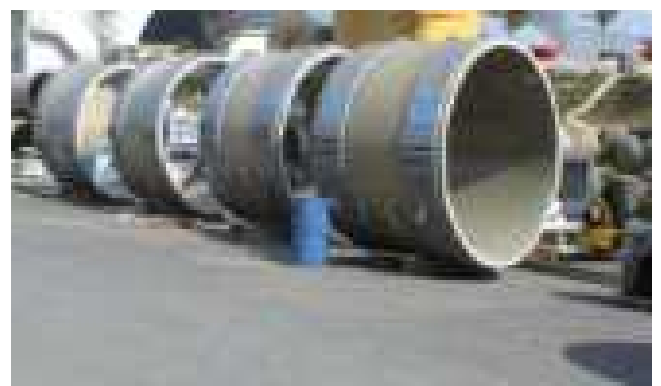
화력발전소 냉각수 배수 라인( \varnothing 2860 )
