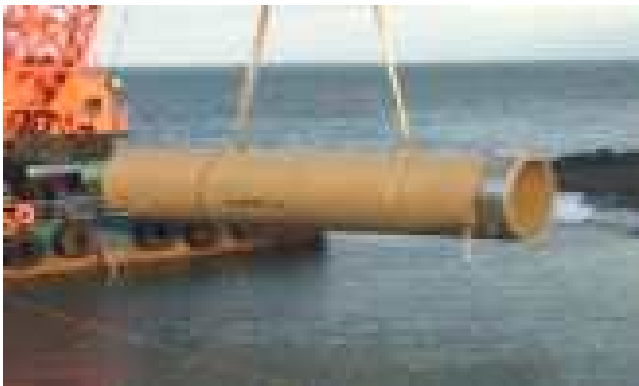
화력발전소 냉각수 배수 라인( \varnothing 2860 )
